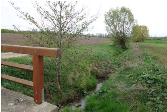
5: Brücke über den Bauerngraben
